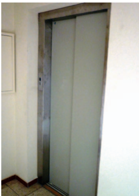
Bild 3: Verkleideter Drehtürrahmen mit Teleskoptür
